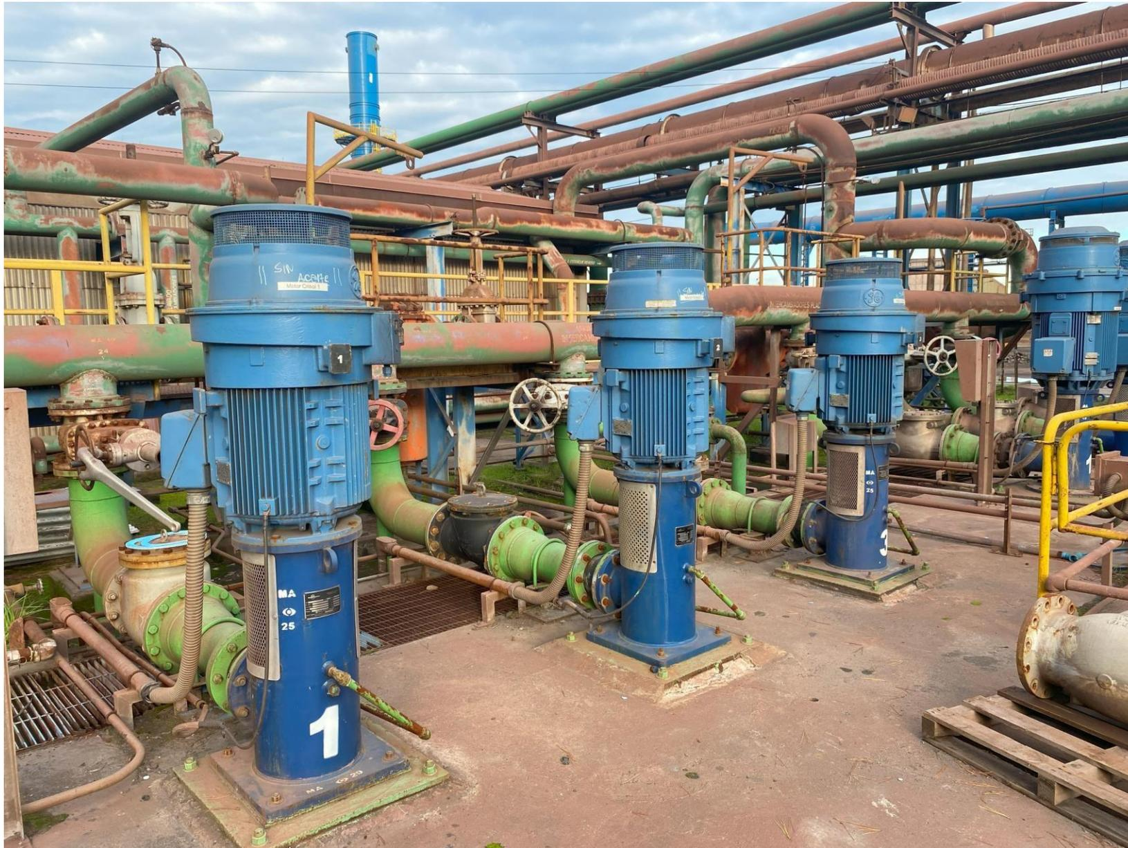
Tres bombas verticales multietapas que impulsan desde el estanque recirculación agua tratada crisol por medio de una cañería de 8"  $\varnothing$ , con un flujo estimado en 250 m<sup>3</sup>/h., pasando por intercambiadores hacia la coraza del crisol.
