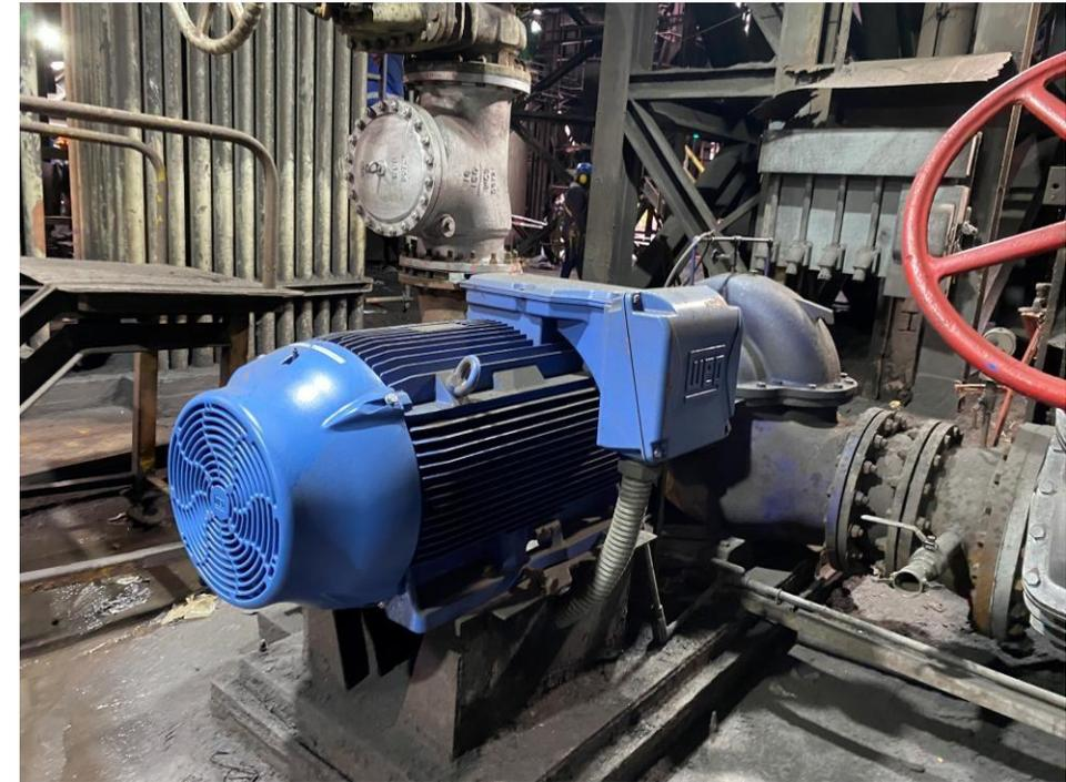
El diseño original del sistema de refrigeración disponía de dos bombas booster de 7500 GPM marca ITT. Posteriormente en 2022 se incorporo una tercera bomba (N°3) marca KSB para mejorar los flujos de refrigeración y confiabilidad de los equipos.
