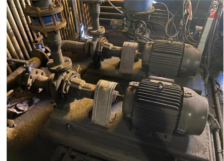
El sistema de refrigeración de tope, se encuentra habilitado en caso de emergencia con dos bombas centrífugas de impulsión de agua limpia.
