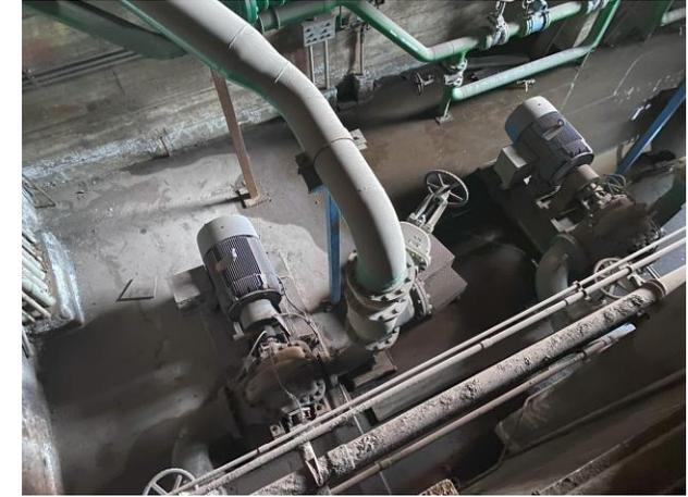
El diseño original del sistema de refrigeración de recirculación disponía de dos bomba centrifugas, que impulsaba desde el lado limpio del estanque de reuso a los sistemas de limpieza de gases y de refrigeración de las VAC, Shut off y agua de sello.
