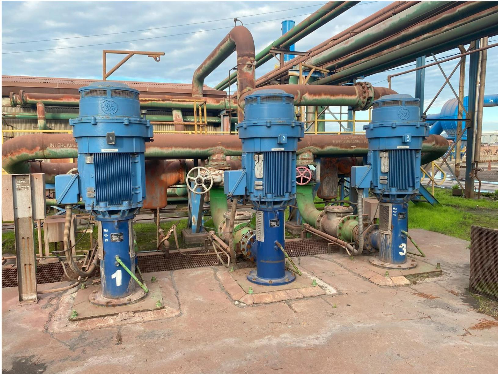
Tres bombas verticales multietapas que impulsan desde el estanque recirculación agua tratada staves por medio de una cañería de 16"  $\varnothing$ , con un flujo estimado en 900 m<sup>3</sup>/h., pasando por intercambiadores hacia las placas de refrigeración (Stave).
